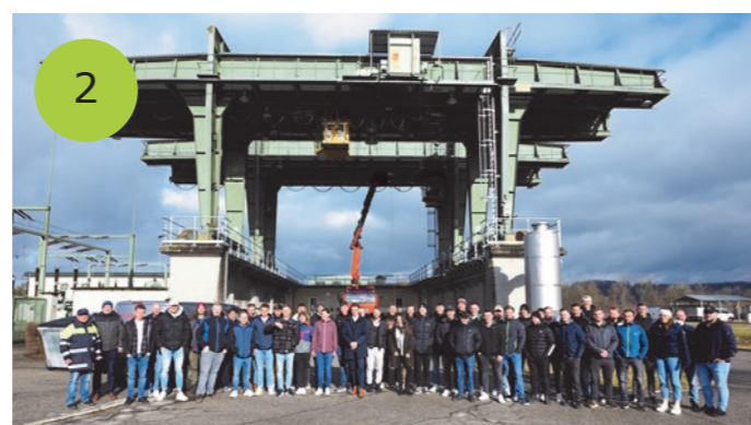
LAUFWASSERKRAFTWERK NEUÖTTING: Fischaufstiegshilfe und Schaltwarte
